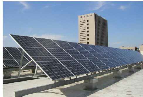
文京キャンパス太陽光発電設備
