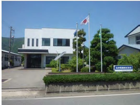
サテライト研究エリアが設置されている企業外観
