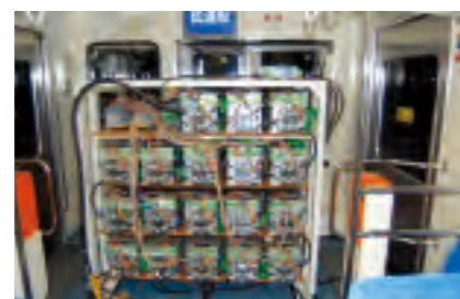
本学科で開発したリチウムイオン電池を用いた電車運転実験
