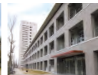
⑥工学部1号館 総合研究棟I
