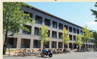
16 総合研究棟III(工学系1号館)
