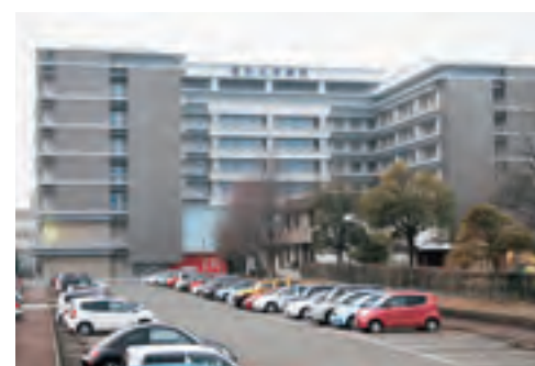
建設中の新病棟
