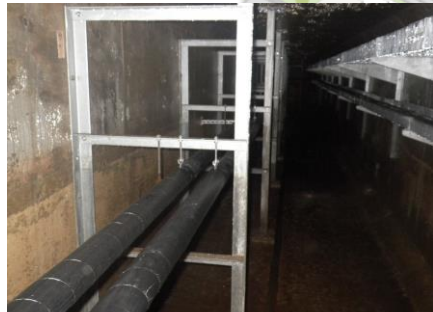
(文京)屋外給排水管改修 1.3億円
