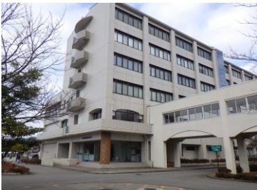
松岡)看護学科校舎(西)屋根防水・外壁改修 0.4億円
