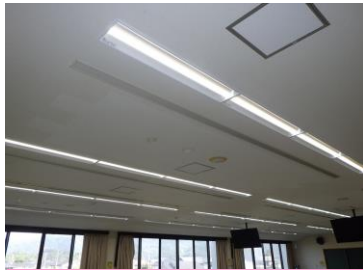
(松岡)看護学科校舎 空調・換気設備改修0.2億円
